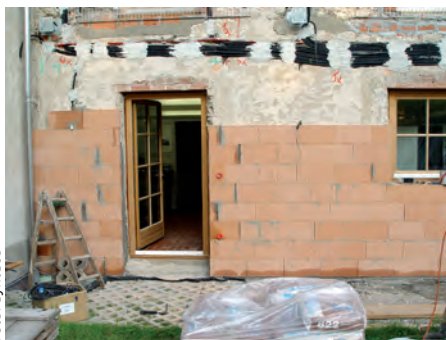
Poroton-WDF in d = 120 \text{ mm} wurde ohne weitere vorherige Maßnahmen direkt (abgesehen von der Verlegung von Kabeln) an der Bestandswand hochgemauert.
